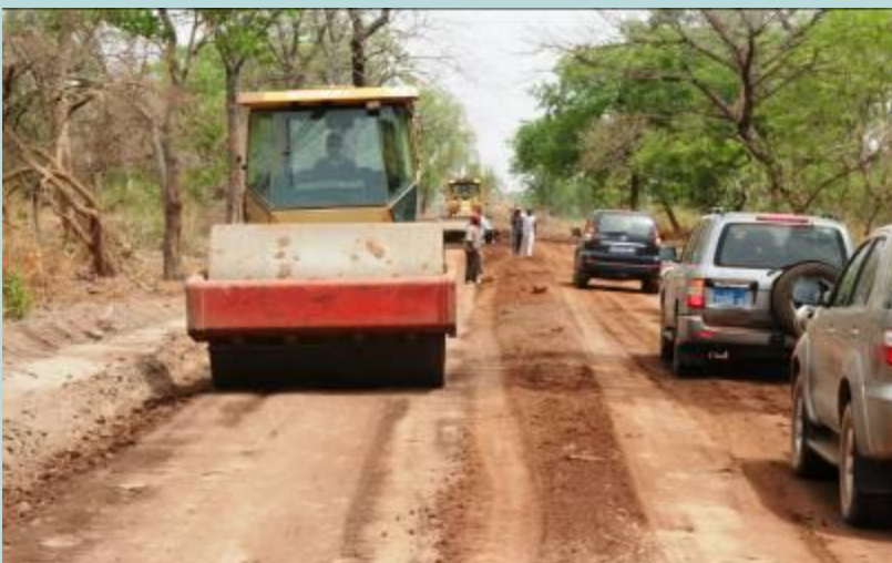
Une vue des pistes de dernière génération en cours de réalisation à Ndorna dans la région de Kolda.
